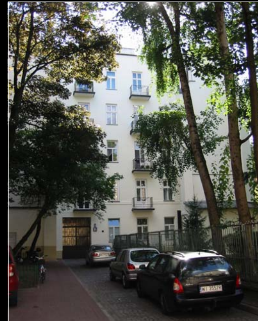
51 Koszykowa Street (2012, renovated)
